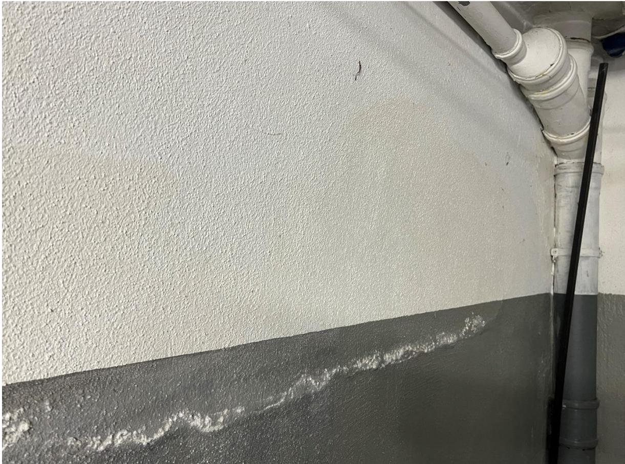
Abbildung 4: Bild aus dem Keller mit Feuchtigkeitsspuren an der Wand
