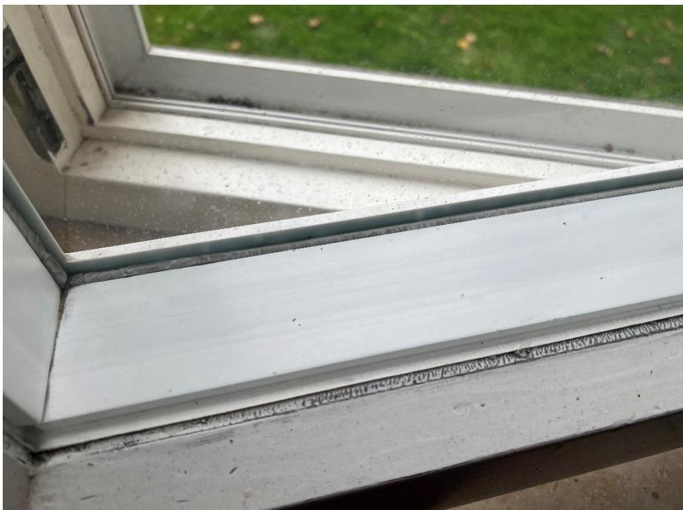
*Abbildung 8: Holzfensterrahmen mit nachträglich eingebautem Vorfenster aus Kunststoff*
